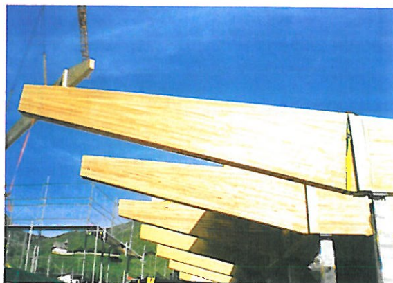
Eine Besonderheit: die Verbindungen zwischen BSH-Träger und Betonstützen sind nicht sichtbar, kamen doch eingeleimte Gewindestangen zum Einsatz.
